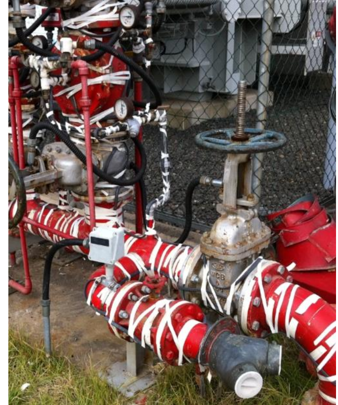
[ 열선 시공 사진 ]
