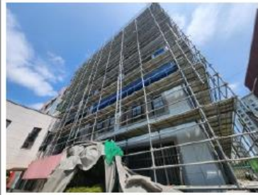
시스템비계 설치 현황(전도 구간 외)
