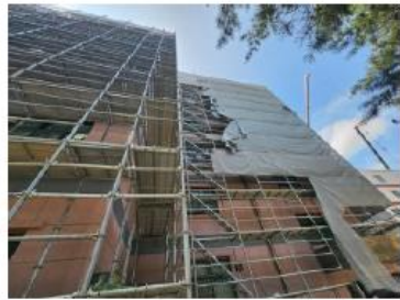
시스템비계 설치 현황(전도 구간 외)
