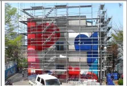
외부비계 설치 사례
