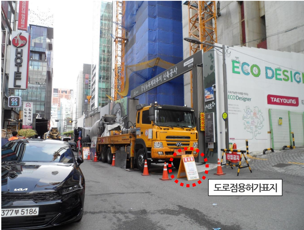
건설장비(콘크리트 타설) 안전확보
