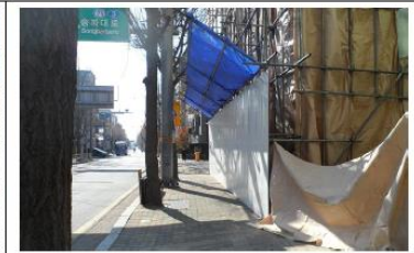
낙하물 방지망, 수직보호망 설치 사례
