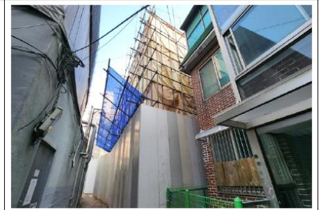
해체공사 낙하물 방지망 설치 사례
