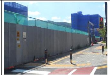
가설울타리(EGI) 설치 사례
