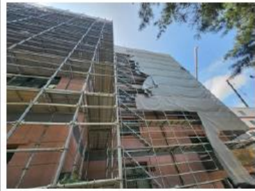
시스템비계 설치 현황(전도 구간 외)
