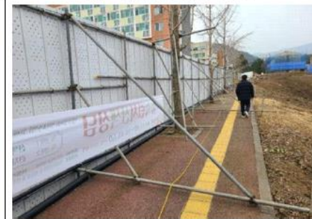
버팀기둥 및 밀동잡이 설치 사례
