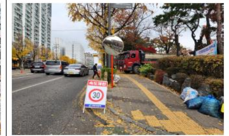
공사안내표지판 설치 사례
