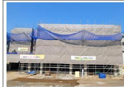
외부비계 분진망 설치 사례
