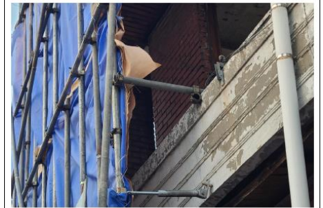
해체공사 강관비계 벽이음 설치 사례
