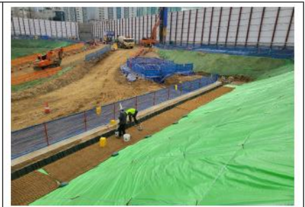
가배수로 설치 사례
