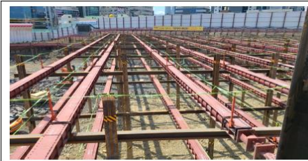
흙막이 버팀대 설치 사례
