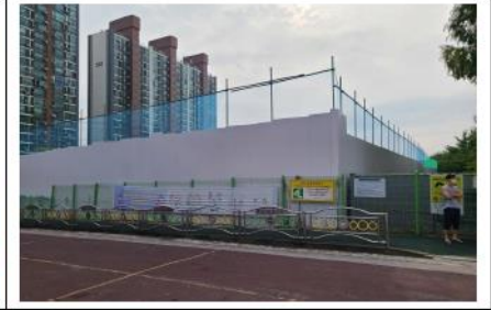
가설방음벽 위 분진망 설치 사례
