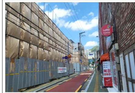
해체공사 외부비계(항공마대) 설치 사례
