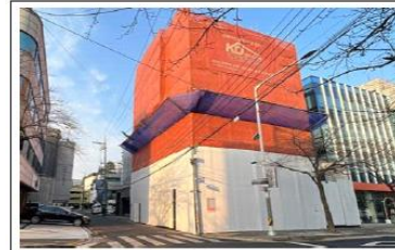
낙하물 방지망, 수직보호망 설치 사례
