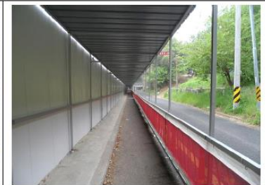
방호선반(안전통로) 설치 사례
