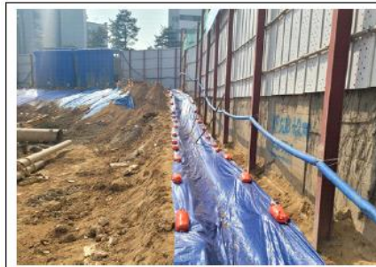
가배수로 설치 사례
