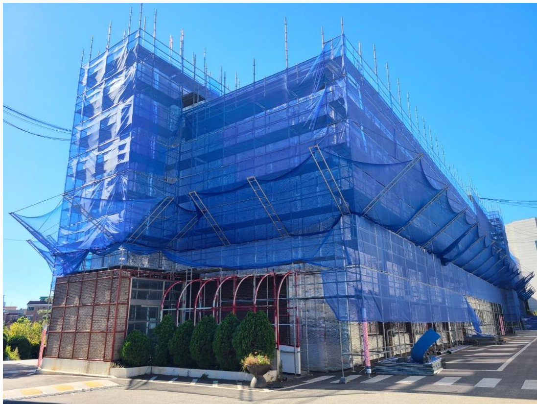
외부 시스템비계+낙하물방지망 설치 사례
