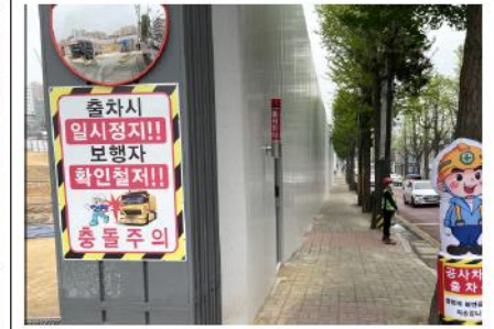
도로반사경 설치 사례
