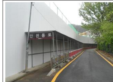
방호선반(안전통로) 설치 사례
