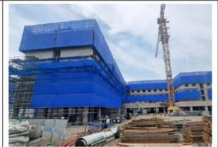
외부비계 분진망 설치 사례
