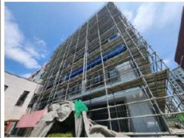
시스템비계 설치 현황(전도 구간 외)
