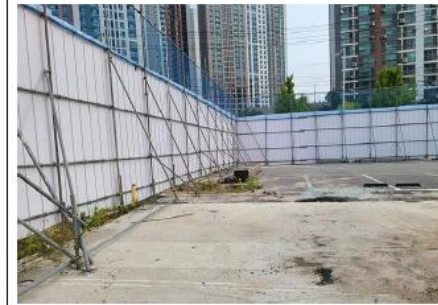
비계식(강관) 설치 사례
