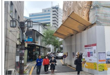
해체공사 낙하물 방지망 설치 사례
