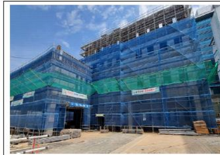
외부비계 설치 사례
