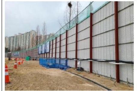
오거식(철골기둥) 설치 사례
