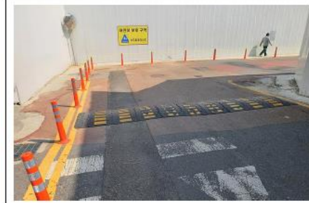
과속방지턱 설치 사례
