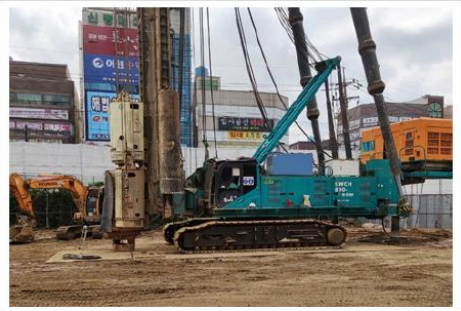
천공기 침하방지 철판 설치 사례
