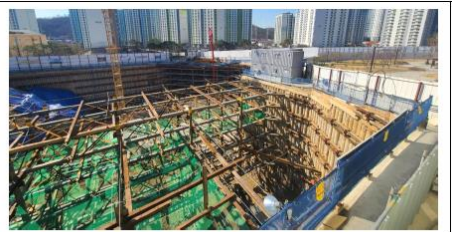
흙막이 버팀대 설치 사례
