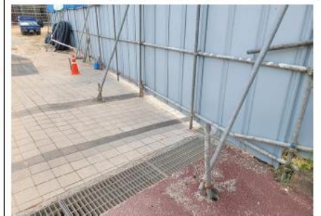
기초 파이프 설치 사례
