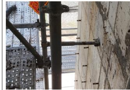
벽이음재 설치 사례
