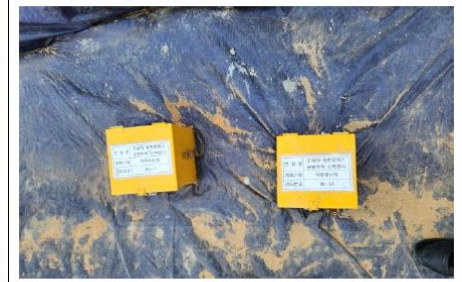
지중 경사계, 지하 수위계 설치 사례
