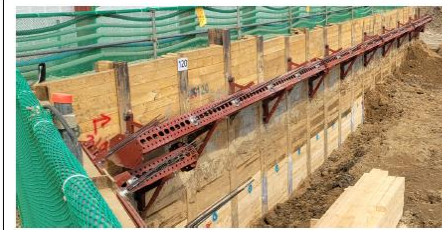
흙막이(토류판+어스앵커) 설치 사례
