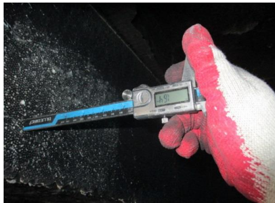
콘크리트 탄산화 깊이 측정
