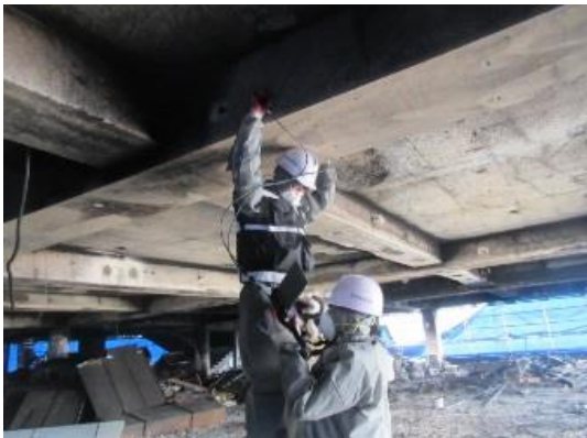
콘크리트 초음파 시험
