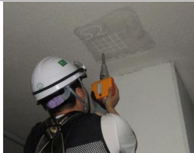
구조부 반발경도 측정
